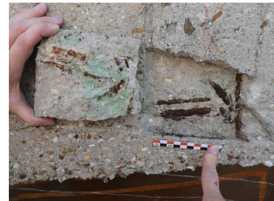
Corrosion dans une réparation par patch
