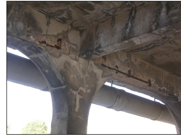
Corrosion du béton armé induite par la carbonatation Pont Camille de Hogues à Châtellerault, 2007 (avant réparation) V. Bouteiller, Univ. Eiffel
